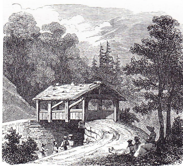
PONT DE ZWEISIMMEN
